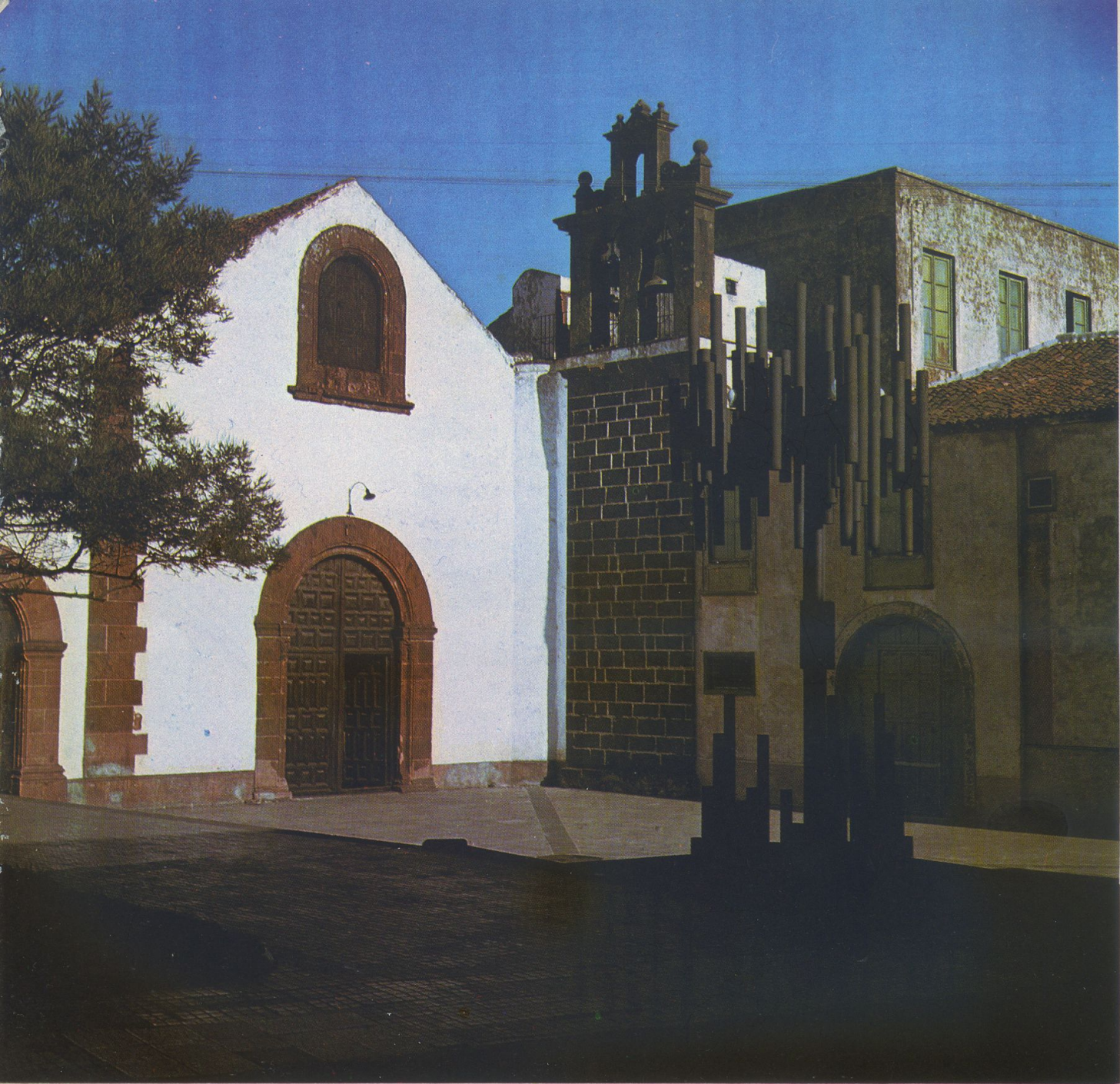
Fachada y espadaña de la actual parroquia de Sto. Domingo de Guzmán, antigua iglesia y convento-estudio dominico de La Laguna. Data de los años 1560-1580.
