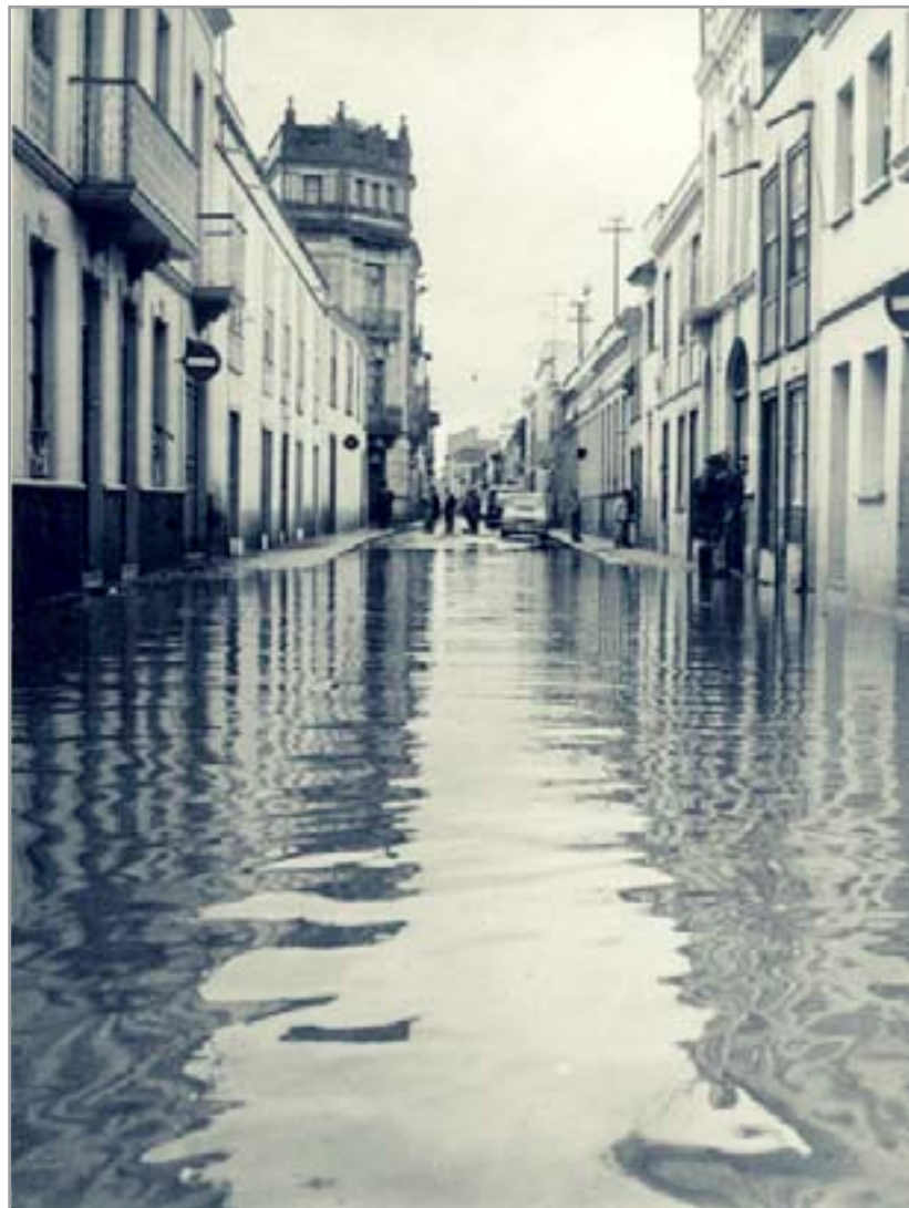
Calle Sol y Orosa de la Laguna. Inundación de 1950. Colección Particular
